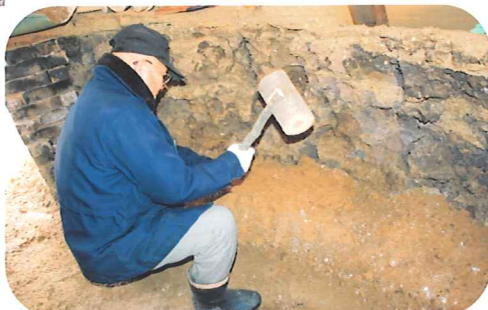
赤土を叩いて叩いてシッカリ突き固めます
