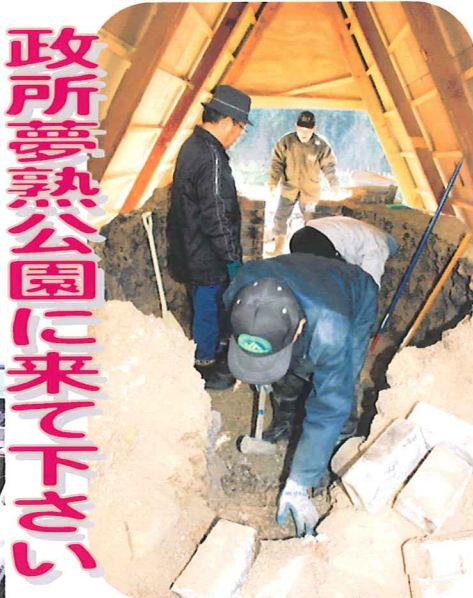
煙突修理も同時進行
