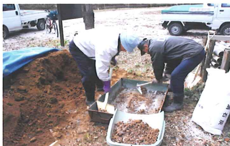
ひび割れ防止に赤土に消石灰を入れてみました
