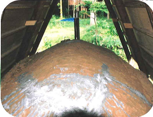
一部手直しされた炭窯も近日中に火入れを行う予定です
